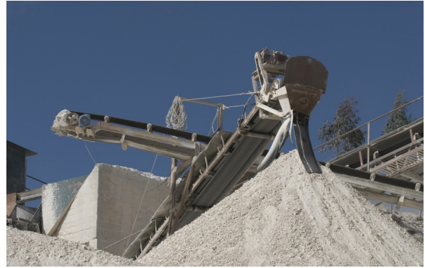
↑ Taş Ocağı Konveyörü
